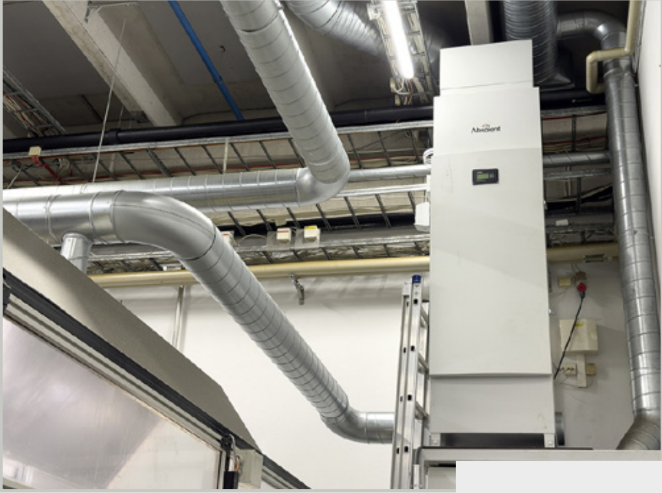
Absolent-suodattimet parantavat ilmanlaatua SAKO:n Riihimäen tehtaalla.
